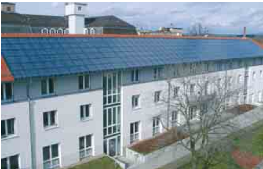
Die mit 324 m 2 Kollektorfläche größte solarthermische Dachfläche in Sachsen befindet sich in Dresden auf dem Altenpflegeheim St. Michael der Caritas. Übers Jahr kann die Hälfte des Warmwasserbedarfs von der Sonne geheizt werden. Das sind 115 000 kWh. Im Haus wohnen 90 Senioren. Quelle: BUSO
